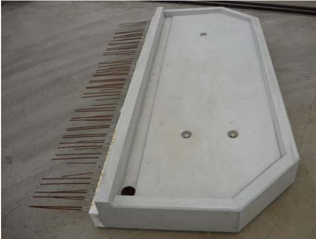
Balkonplatte als Fertigteil mit Aufkantung und Ablauf
