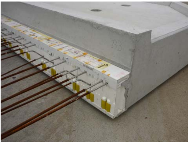
Eingebaute thermische Trennung mit Bewehrung
